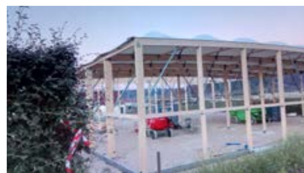
Montage de la toiture
