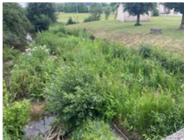
Avant travaux à Pansey
