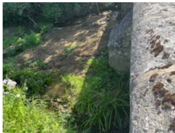
Après travaux à Pansey
