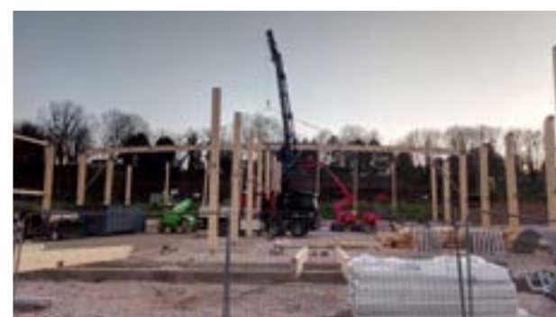
Montage de la charpente
