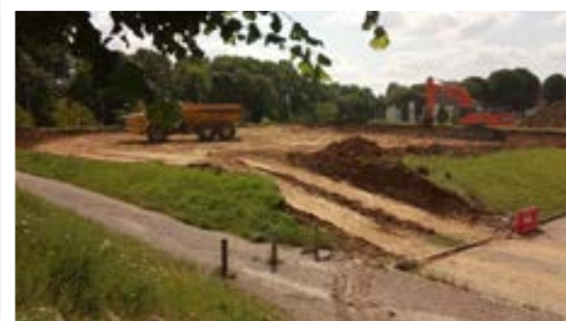
Terrassement des tennis
