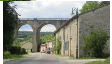
Viaduc de Thonnance-les-Moulins (source : CCBJC)
