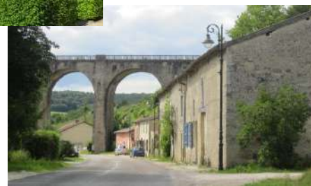
Viaduc de Thonnance-les-Moulins
