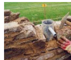
Insertion de nichoirs dans le bâti ancien
