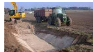
Création de mare dans la Marne (51)
