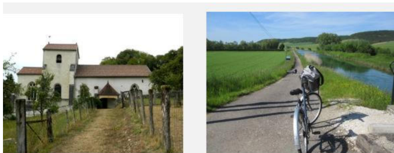
Aménagements de venelle et de chemins de ceinture à Effincourt et Saint-Urbain (CCBJC)
