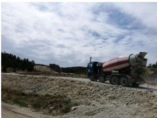
Travaux pour l'installation d'un méthaniseur à Fronville – (source : Communauté de Communes du Bassin de Joinville en Champagne)
