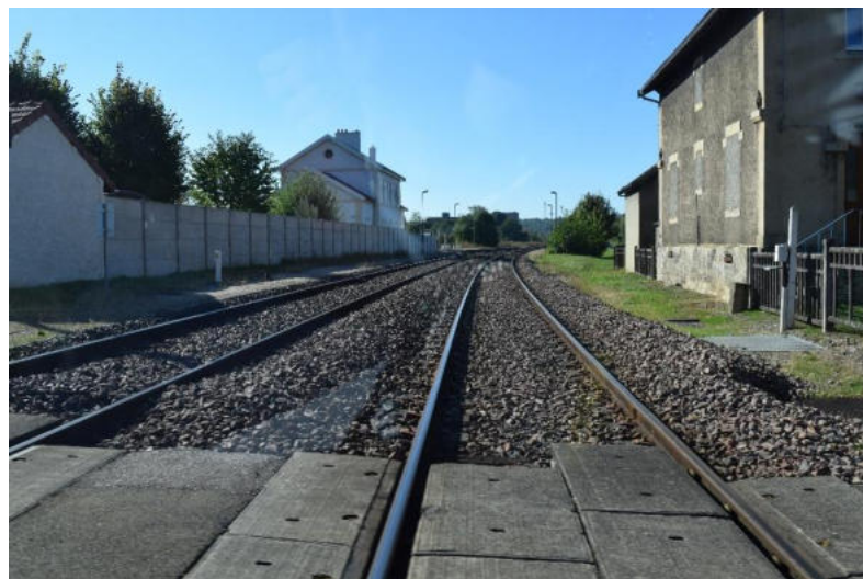
Arrêt de bus (ligne Joinville-Roches) à Bouzancourt et gare de Joinville-en-Champagne – (source : Diagnostic SCoT – volet transport)
