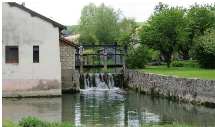
Les écluses et vannes de Courcelles-sur-Blaise, un patrimoine lié à l'eau (source : Even conseil)
