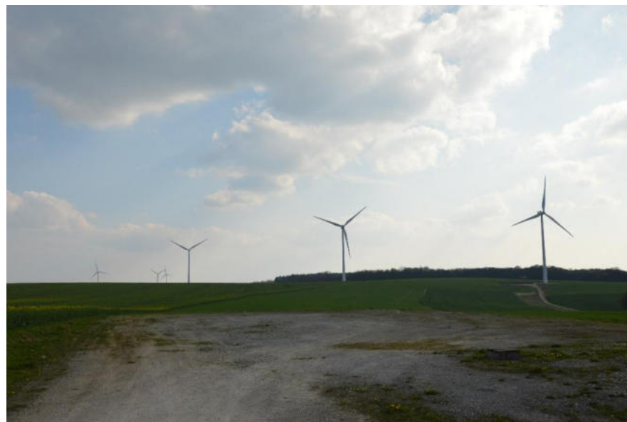
Eoliennes sur le territoire de la CCBJC- (source : Communauté de Communes du Bassin de Joinville en Champagne)
