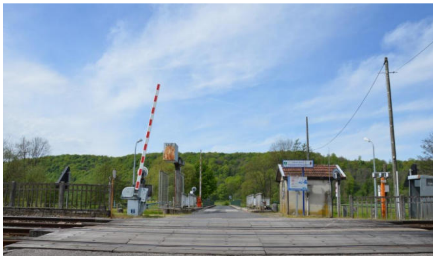
La voie ferrée, une rupture physique dans les continuités écologiques contraignant les déplacements de la biodiversité – ici à Autigny le Grand (source : CCBJC)
