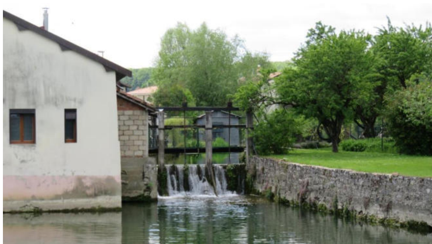
Les vannes et écluses, des obstacles à l'écoulement des eaux - Courcelles-sur-Blaise (source : Even conseil)
