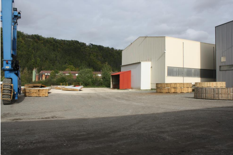
Vue 2 – Vers les limites Nord du site
