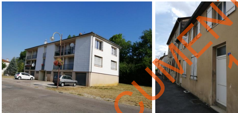
Logements sociaux Hamaris à Poissons et Rupt
