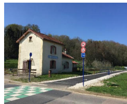
Dommartin-le-Saint-Père (source : Citadia)
