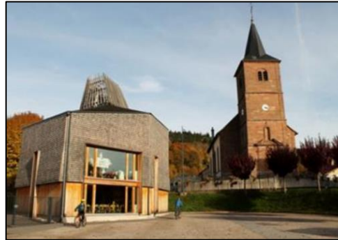
Bâtiment périscolaire à Tendon (88) utilisant des matériaux locaux et biosourcés (bois, paille...)
