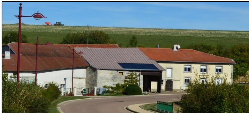
Dispositif de production d'énergie solaire installé sur un bâtiment de stockage agricole le long de la RD960 sur la commune de Saudron –
