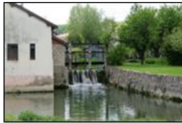
Ecluses et vannes de Courcelles-sur-Blaise (source : Even conseil)
