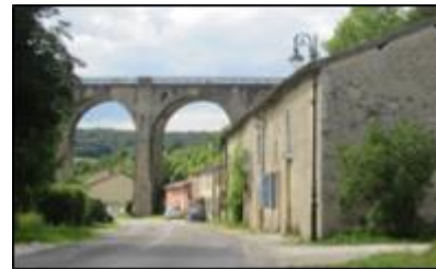
Ancien pont ferroviaire de Thonnance-les-Moulins (source : CCBJC)
